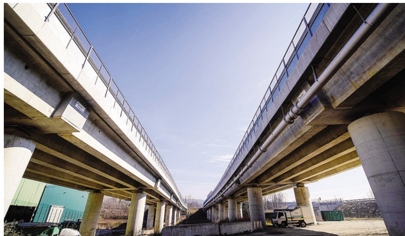
La parte finale della tangenziale ad Albate: proprio qui avrebbe dovuto innestarsi il secondo lotto diretto ad Albese
