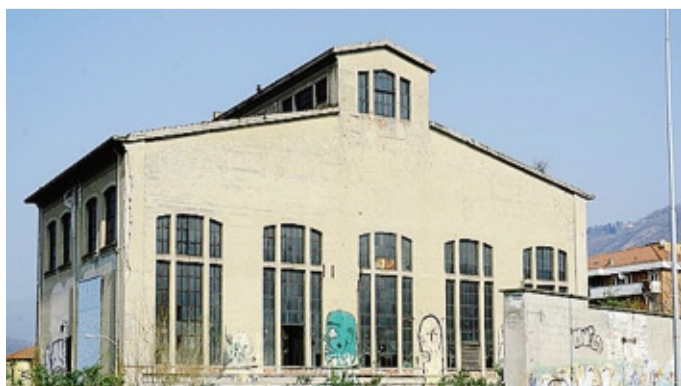
La Santarella, l'ex centrale termica della Ticoso
