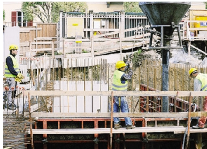
Operai al lavoro su un cantiere edile
