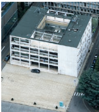
L'ex Casa del Fascio vista dall'alto
