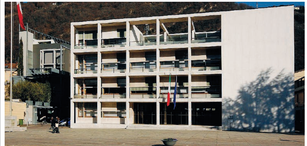
Un'immagine dell'ex Casa del Fascio, oggi Palazzo Terragni. Verranno organizzate visite guidate nell'edificio
