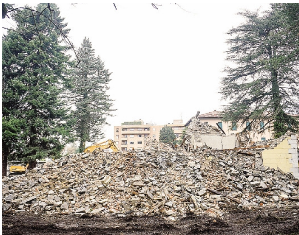
Un cumulo di macerie dove sorgeva Villa Feloy, in via Petrarca BUTTI
