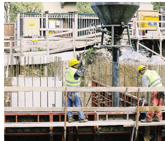
Operai al lavoro in un cantiere ARCHIVIO
