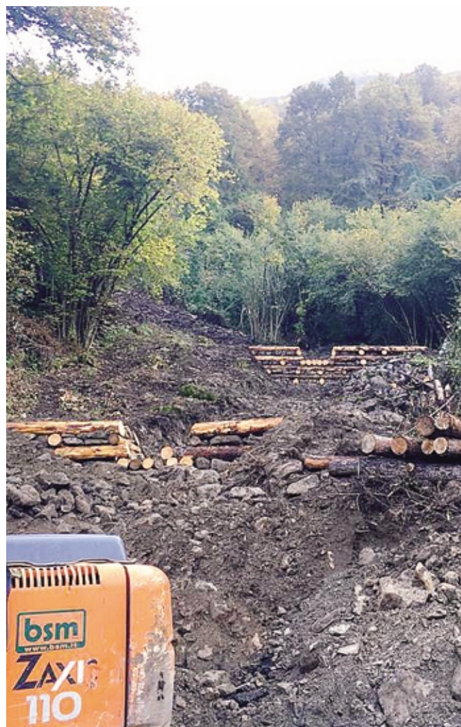
Uno dei numerosi lavori svolti ad Argegno contro il dissesto
