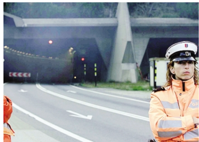
Uno scorcio del tunnel del Gottardo che sarà raddoppiato
