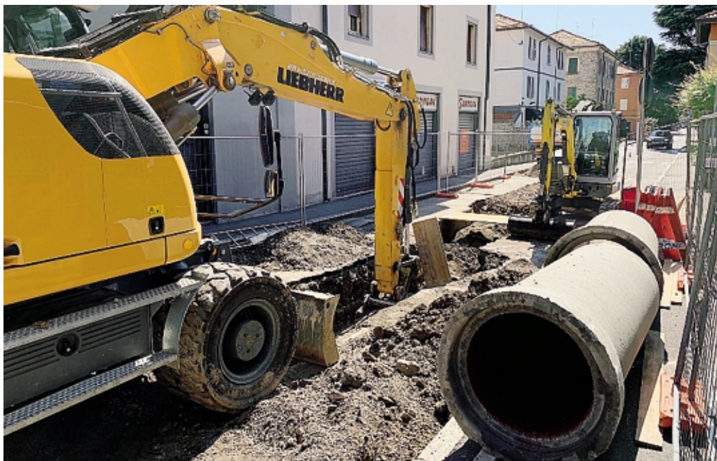
Lo scavo in via Volta, nel settembre scorso BARTESAGHI
