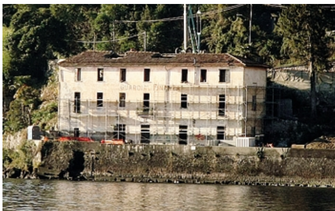
Il cantiere dell'ex caserma della finanza visto dal lago
