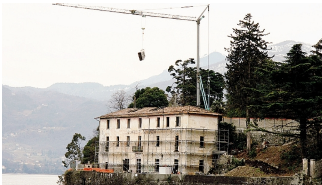
La gru e i ponteggi montati sulle facciate dell'ex caserma della guardia di finanza FOTOSERVIZIO SELCA
