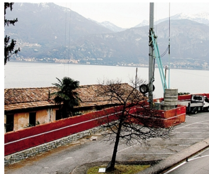
La zona interessata dai lavori di messa in sicurezza del tetto
