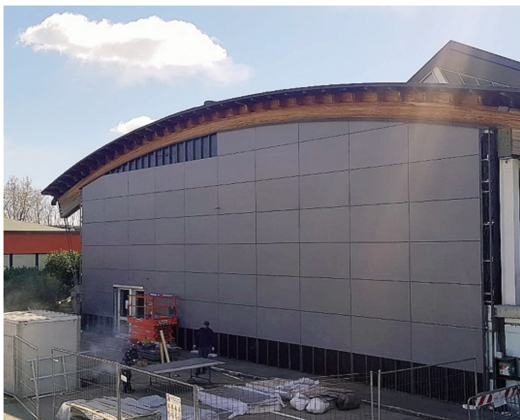
L'intervento in corso alla palestra di via Mascherpa a Montano
