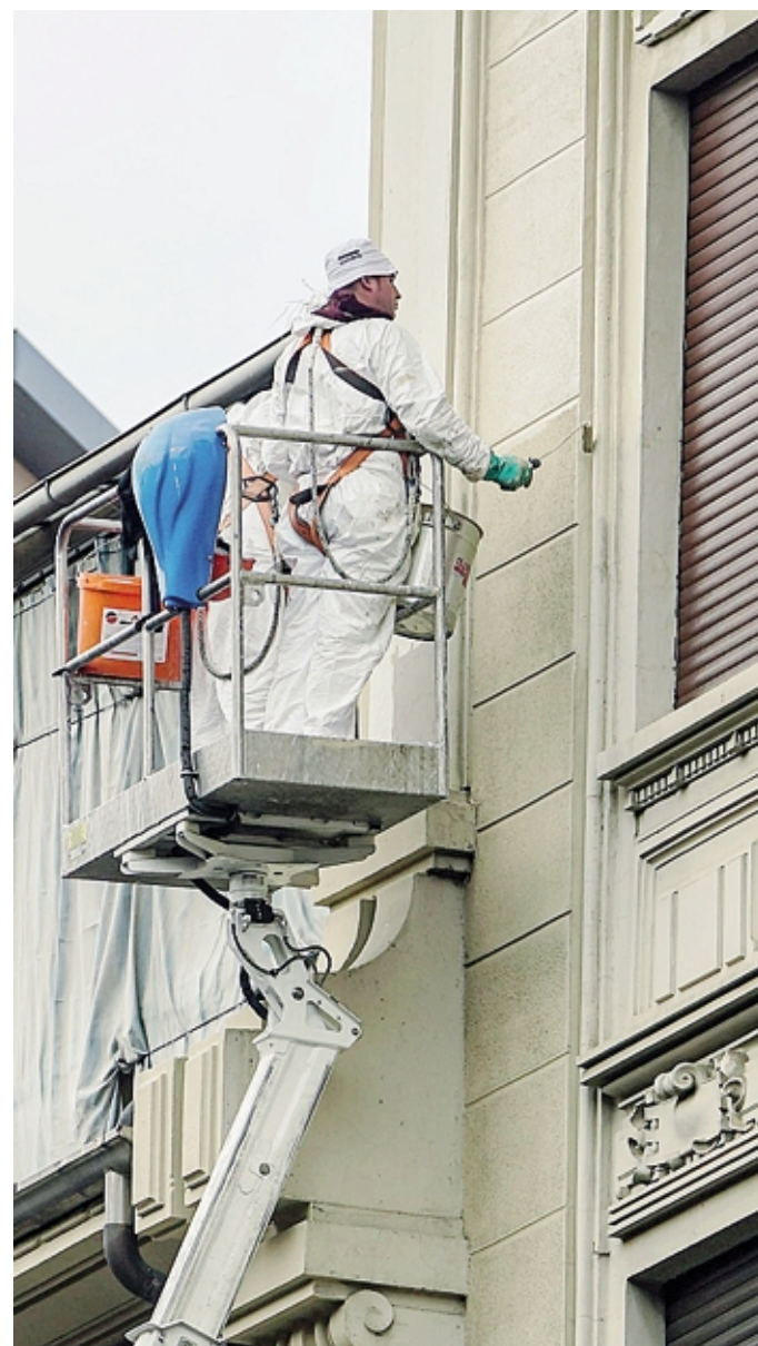
Un intervento sulla facciata di un palazzo d'epoca
