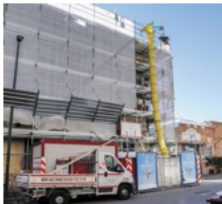
Lavori di ristrutturazione ANSA
