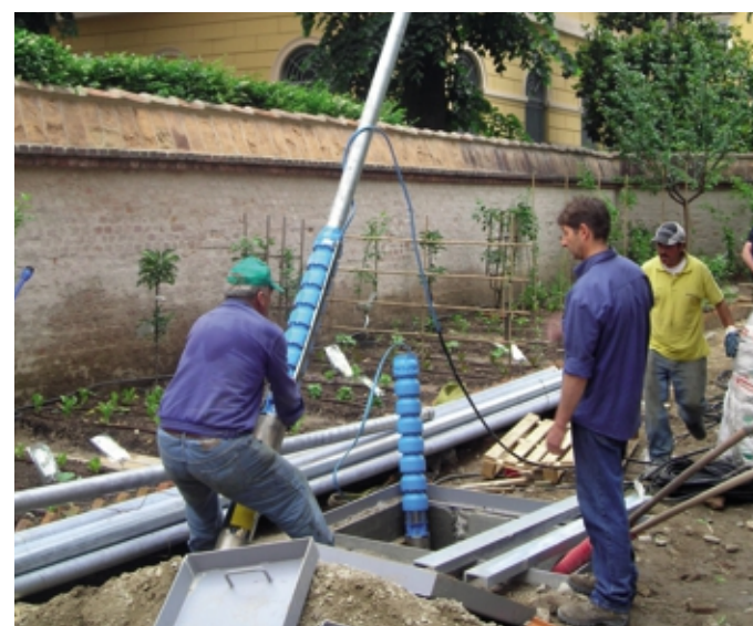
La realizzazione di un impianto geotermico
