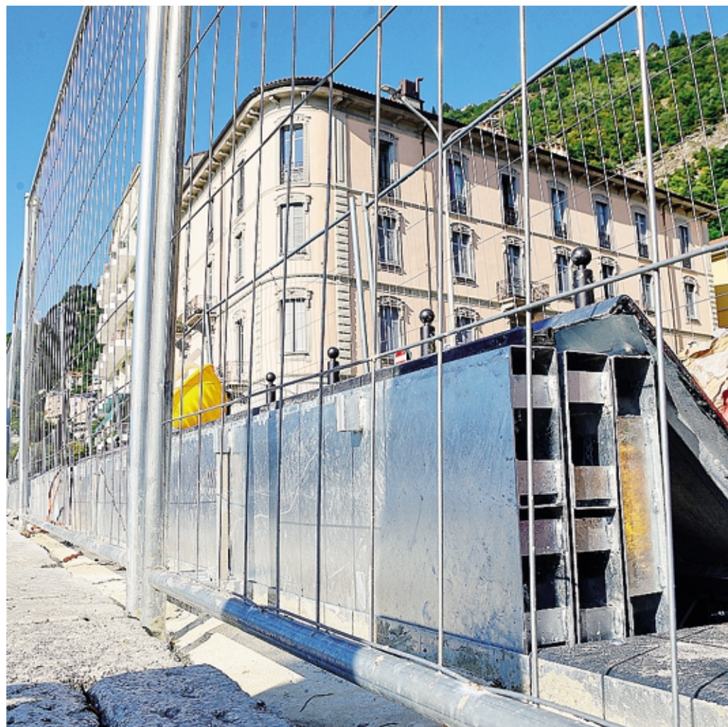
Le prime prove delle barriere antiesondazione effettuate nel settembre scorso a Sant'Agostino
