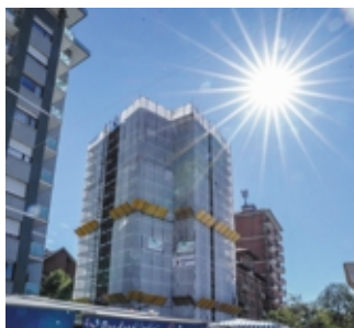
Impalcature montate sulle facciate
