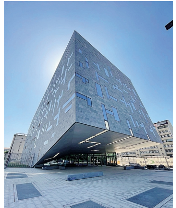
Uno degli edifici realizzati a Milano con cemento sostenibile
