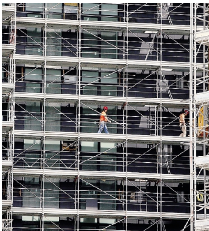
Un intervento di riqualificazione energetica di un condominio
