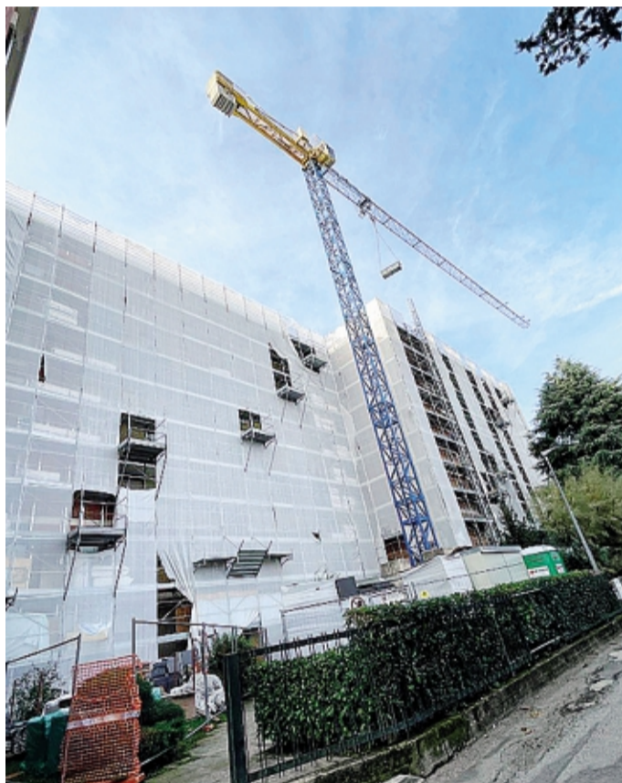
Un edificio in ristrutturazione
