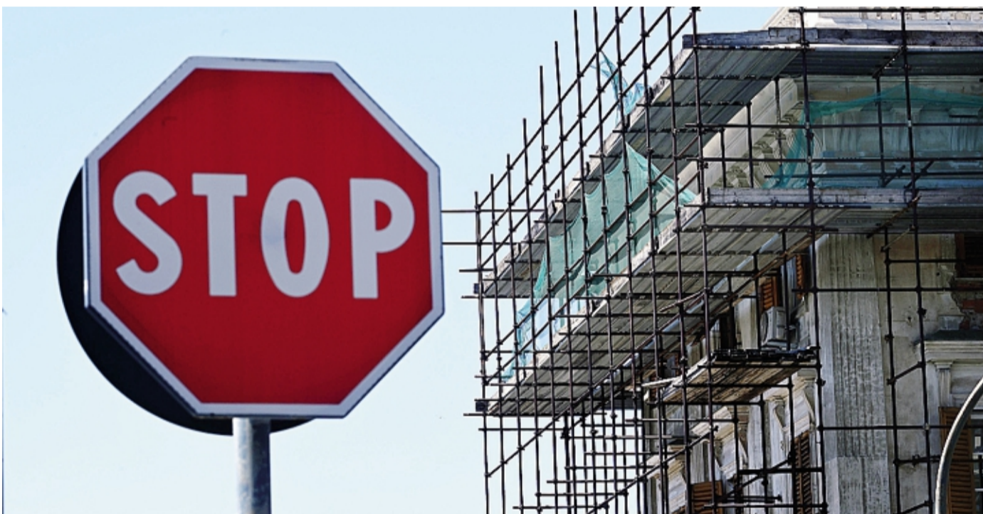
L'appello e le problematiche sollevate riguardano i condomini dove sono in fase di ultimazione i lavori ARCHIVIO
