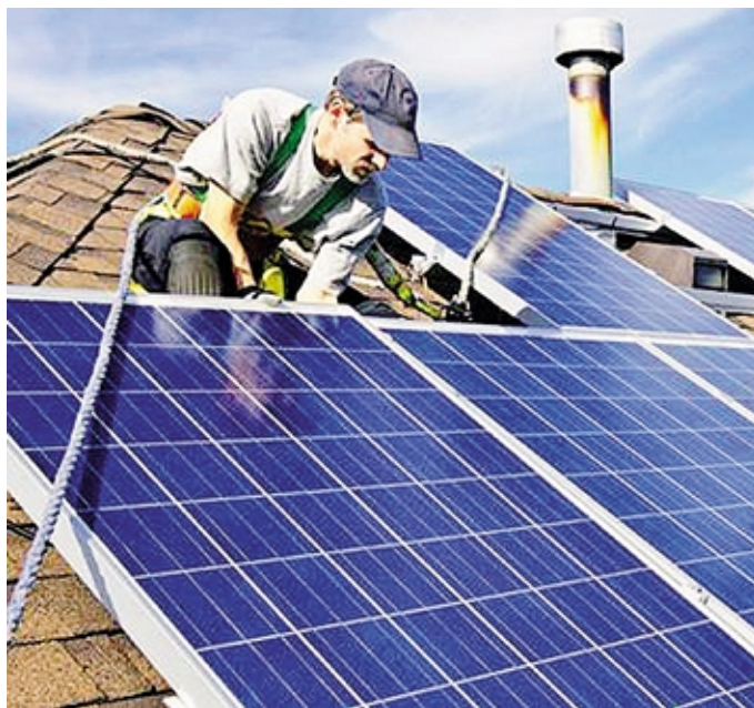
L'installazione dei pannelli fotovoltaici su una copertura
