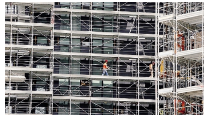
Lavori di riqualificazione energetica di un condominio
