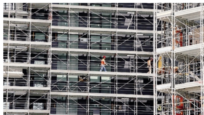
Cantiere aperto per la riqualificazione di un condominio
