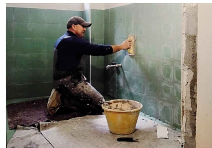
Lavori di rifacimento del bagno
