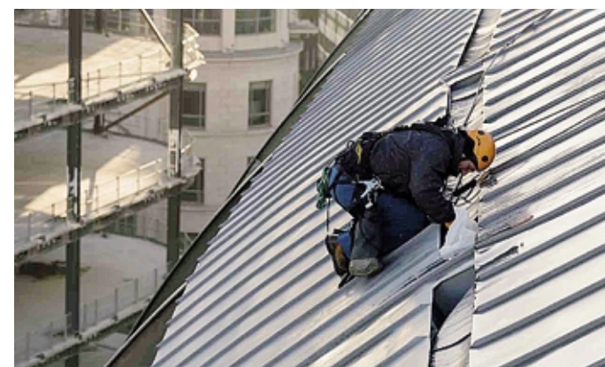
Lavori di riqualificazione sul tetto di un edificio ARCHIVIO
