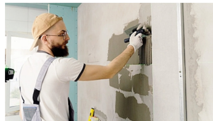
Lavori di risanamento di un seminterrato
