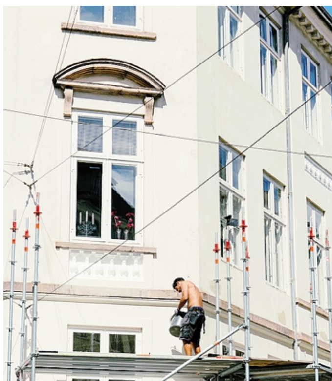
Cantiere edile con rifacimento degli infissi esterni UNSPLASH
