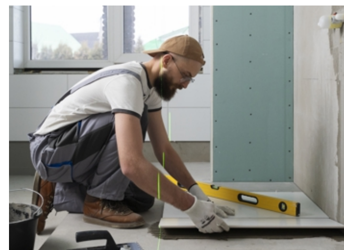
Lavori di manutenzione in un bagno FREEPIK
