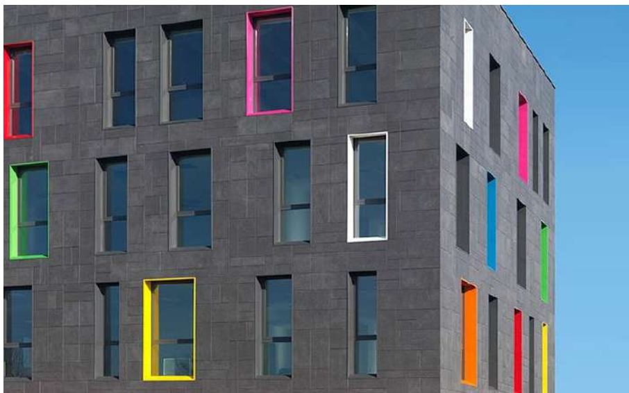
Facciata non ispezionabile
