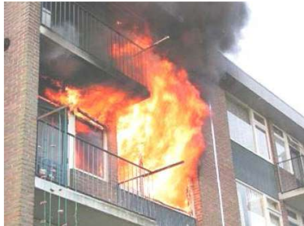
cambiamento dell'estensione e della posizione delle fiamme dovuti ad un oggetto orizzontale sopra la finestra
