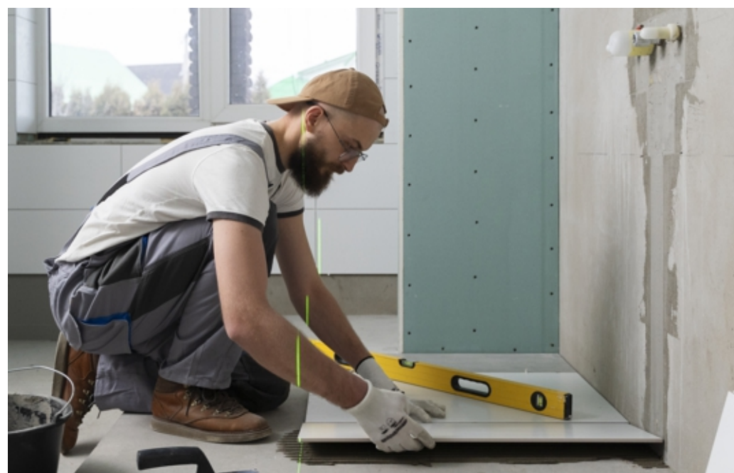
Lavori di riqualificazione in un appartamento
