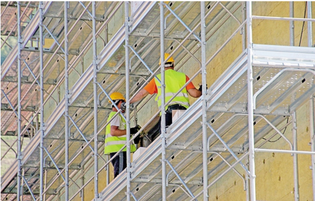
Operai edili in un cantiere
