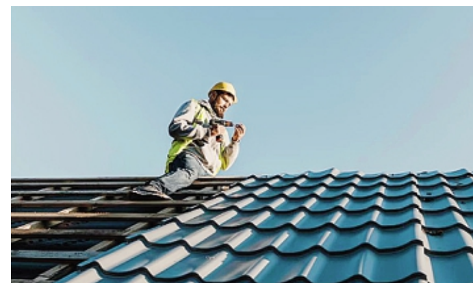
Sostituzione delle tegole su un tetto FREEPIK
