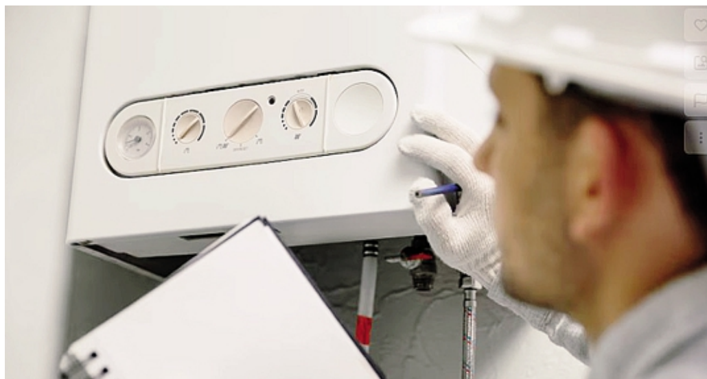
Tecnico installatore di caldaie FOTO FREEPIK
