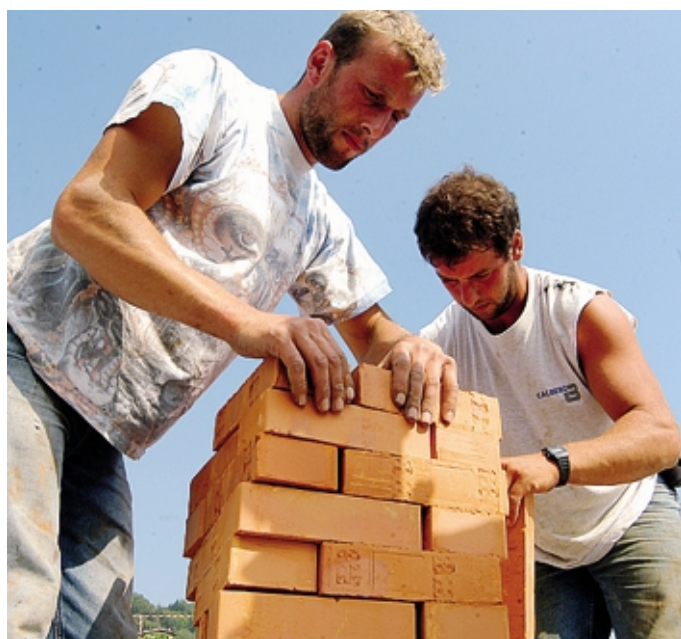
Operai al lavoro nella costruzione di un muretto
