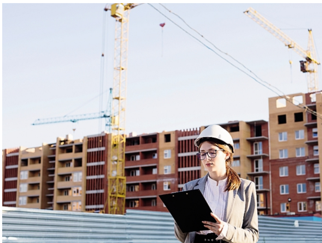
Il cantiere di nuovi edifici residenziali FOTO FREEPIK
