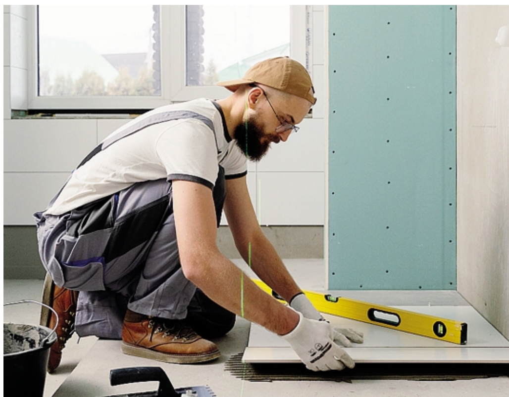
Lavori di rifacimento della pavimentazione del bagno
