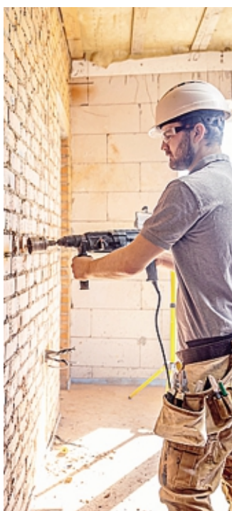
Lavori di manutenzione
