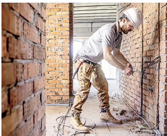
Lavori di ristrutturazione di un immobile
