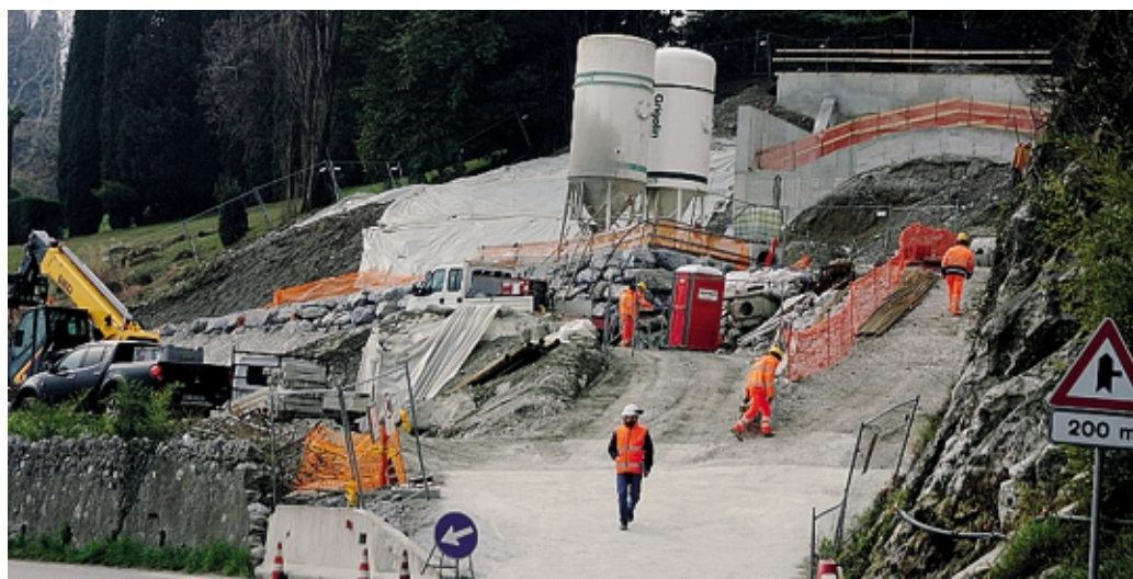
Il cantiere della variante a Griante ARCHIVIO
