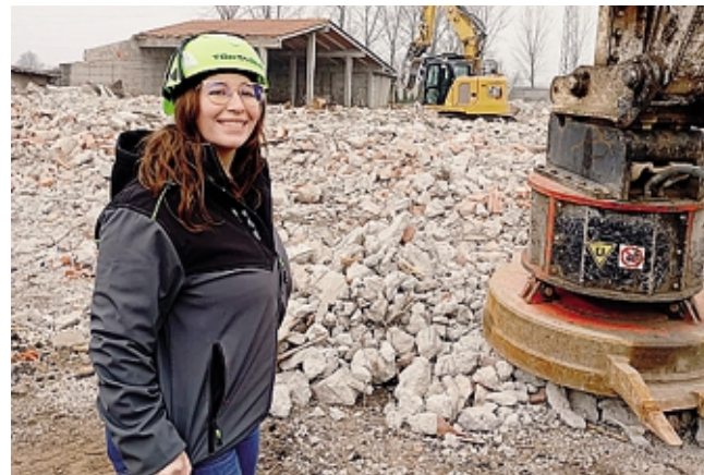
Una collaboratrice di Toptaglio in cantiere
