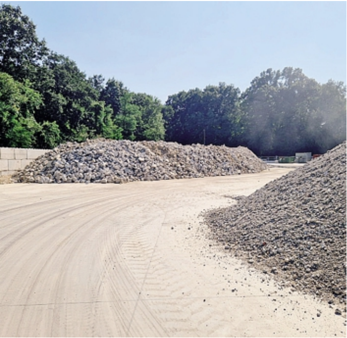
CDM recuperato, Holcim Aggregati Calcestruzzi di Gorla (VA)
