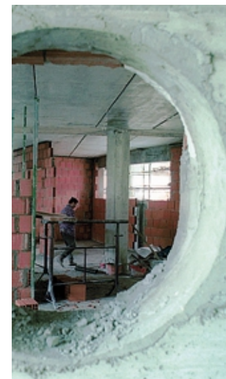
Lavori in corso
